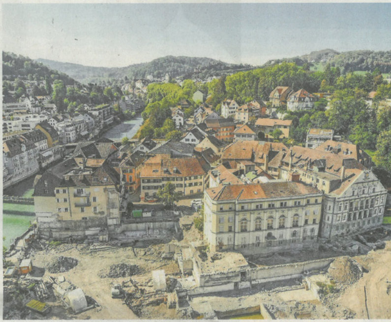
Unerwartete Schwierigkeiten beim Aushub: Blick auf die Thermalbad-Baustelle im September.
