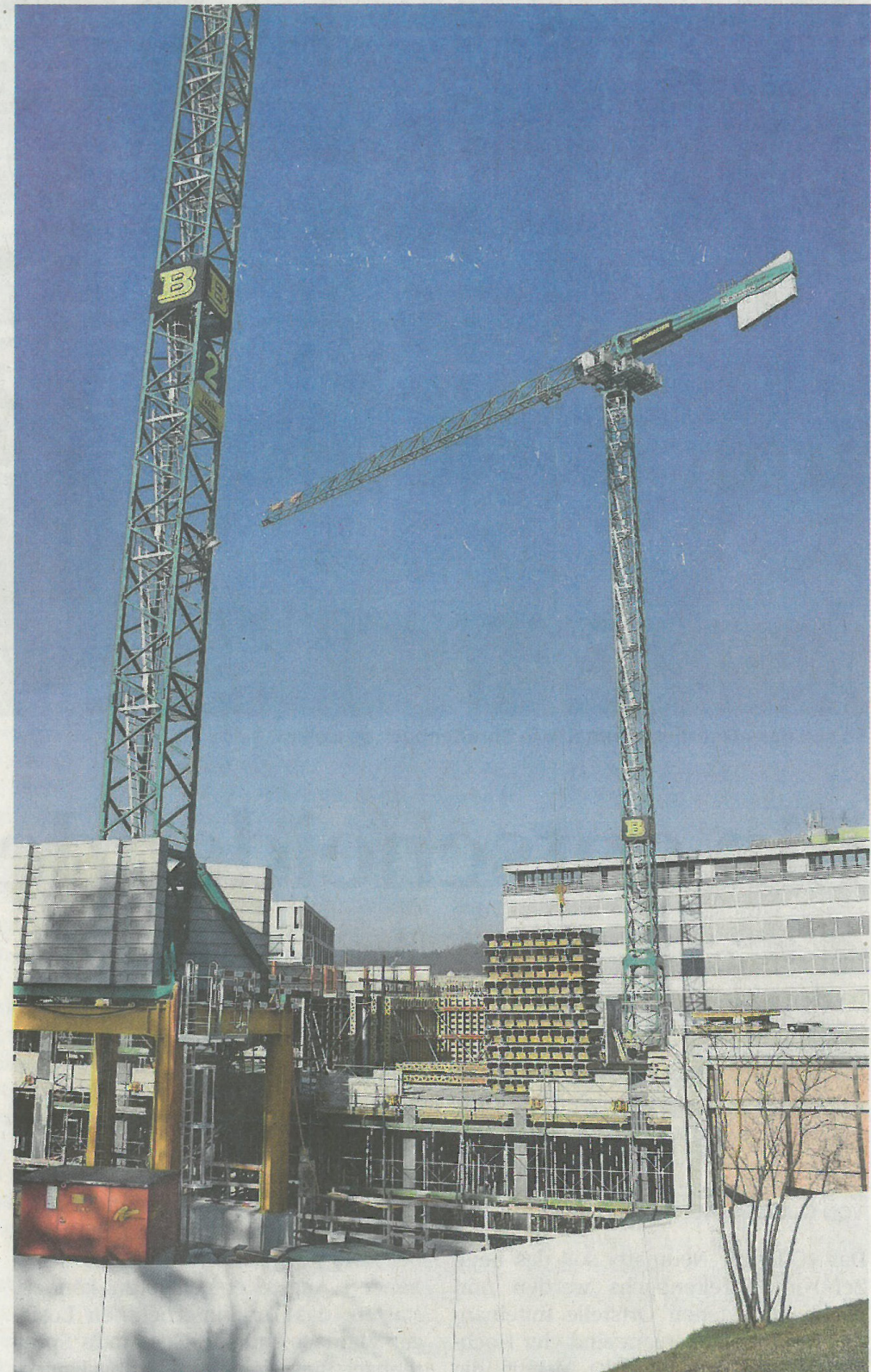
Zurzeit wird das erste Obergeschoss im Rohbau erstellt.
