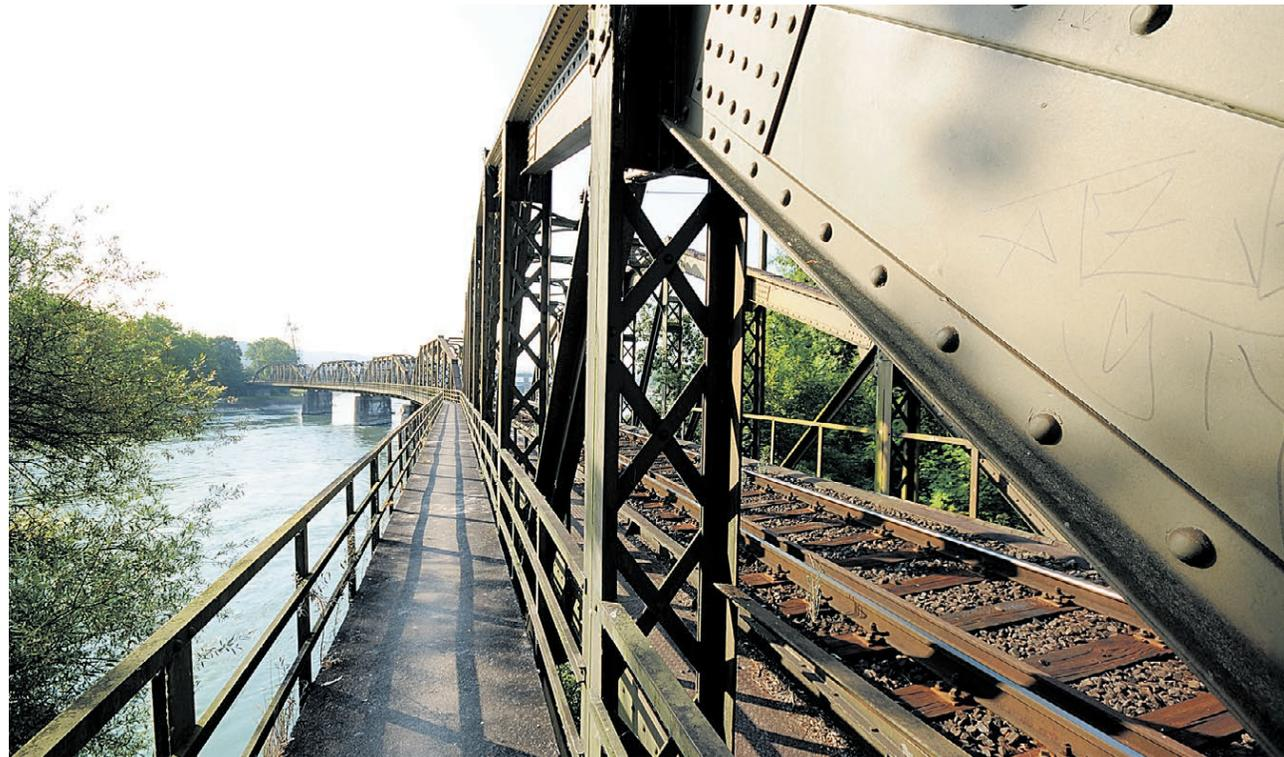
Neben den Brückenpfeilern wird auch der Fussgängersteg der Aarebrücke komplett erneuert. Die Betonplatten werden durch Gitterroste und Riffelbleche ersetzt.
