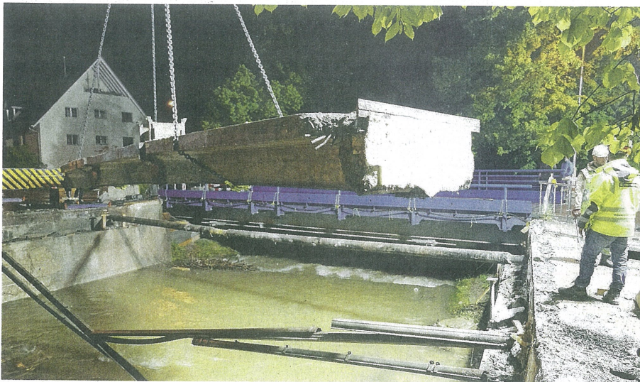
Das letzte Betonteil wurde um 0.25 Uhr herausgerissen.
