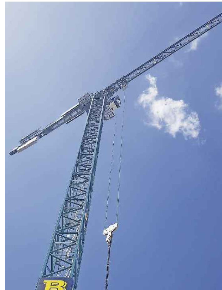
Schwindelerregend: 63 Meter hoch ist dieser Kran. Bild: Martin Rupf
