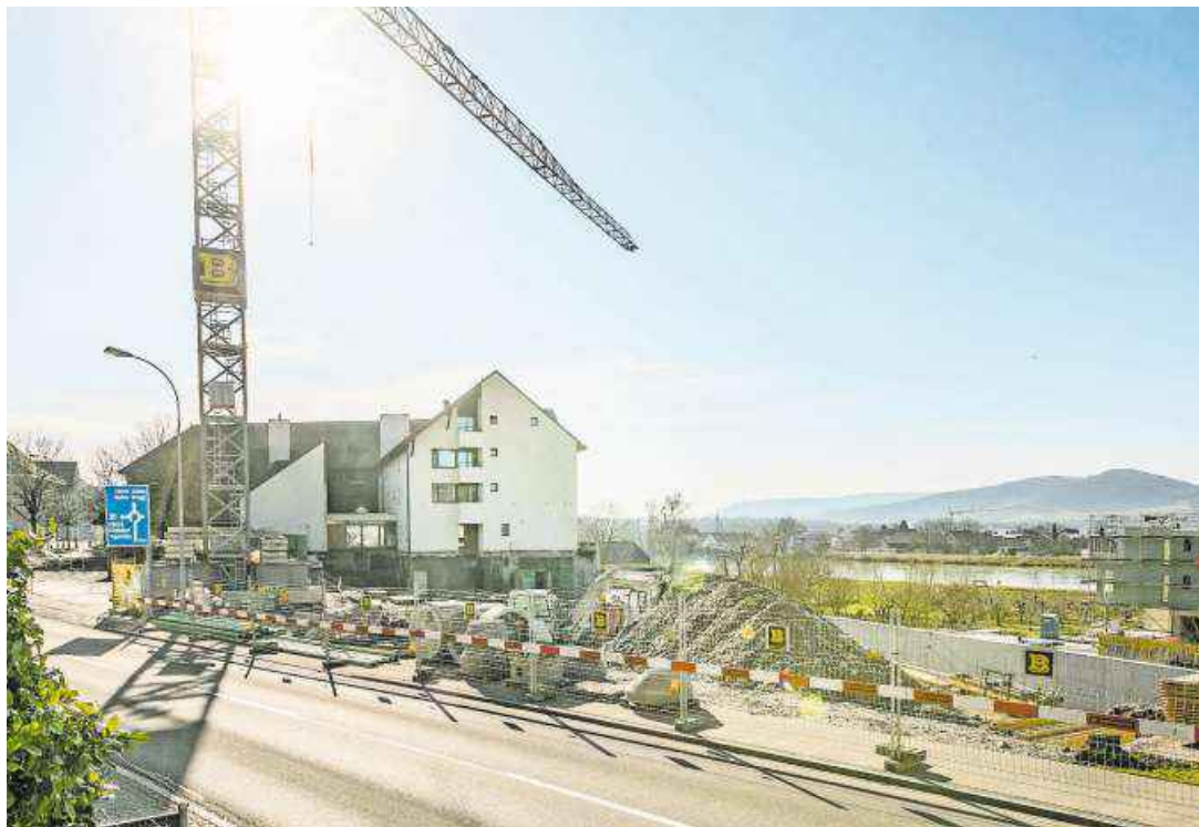
Das Untergeschoss des neuen Gebäudes nimmt bereits Formen an.
