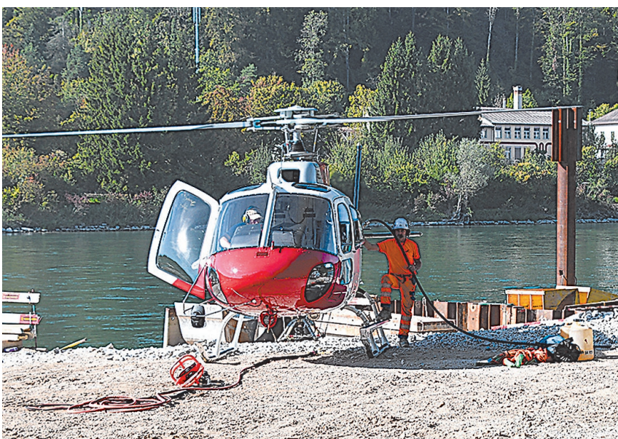
Der Heli der Glarner Firma Heli-Linth wird direkt vor Ort «mobil» betankt.
