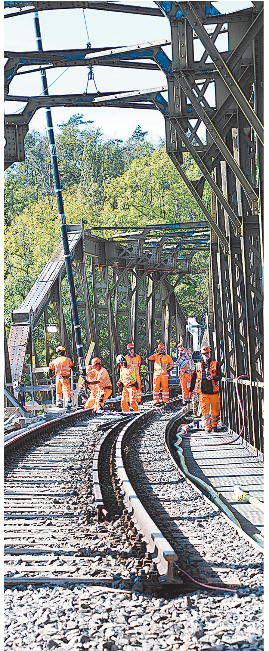
Die Bohrlöcher, die quer durch den Pfeiler führen, sind vorgebohrt worden, sodass die Mitarbeiter am Freitag die neun Meter langen Stangen auf den Pfeilern nur noch in Empfang zu nehmen und in die Löcher einzuführen haben.
