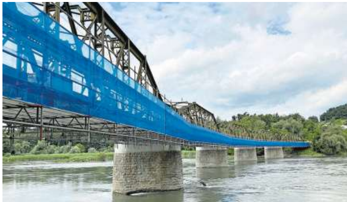
Die Erneuerung der Brücke kostet 16,2 Millionen Franken. Bild: pz
